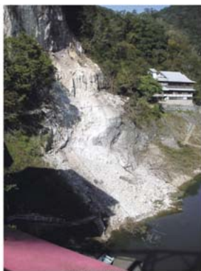
帝釈峯 崩落現場
