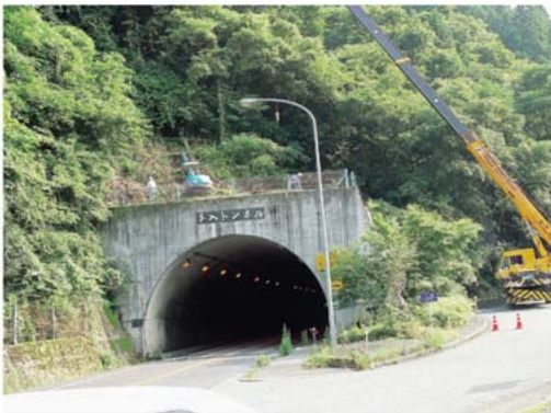
建設工事現場
