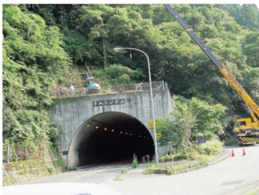
建設工事現場
