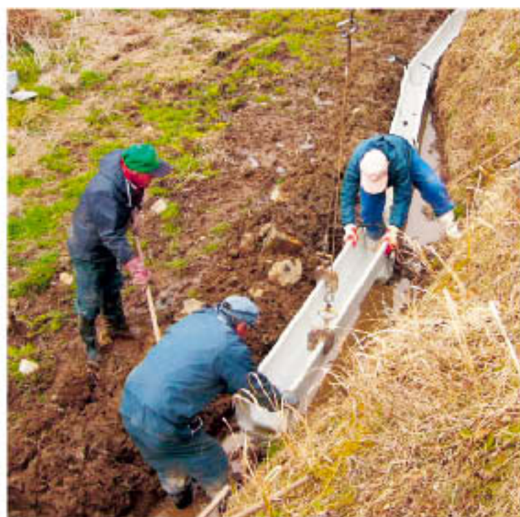
水路補修（上野）
