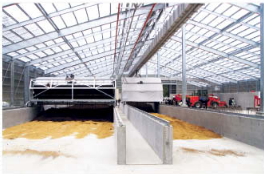
堆肥センター
