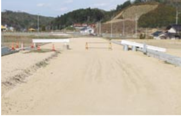
小島バイパス工事
