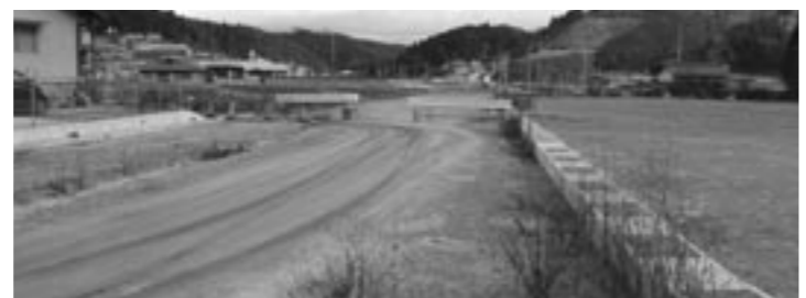
工事中の小島バイパス
