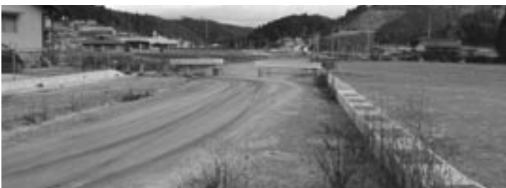
工事中の小島バイパス
