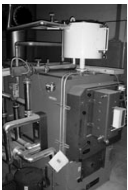
木質チップボイラー
