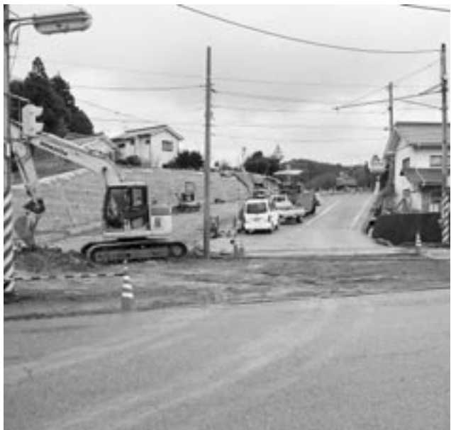
井関開発入口の県道改良工事
