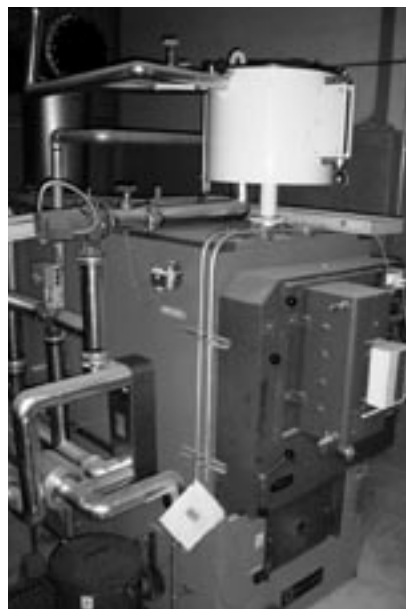
木質チップボイラー
