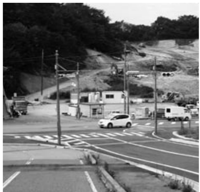
井関定住団地工事中
