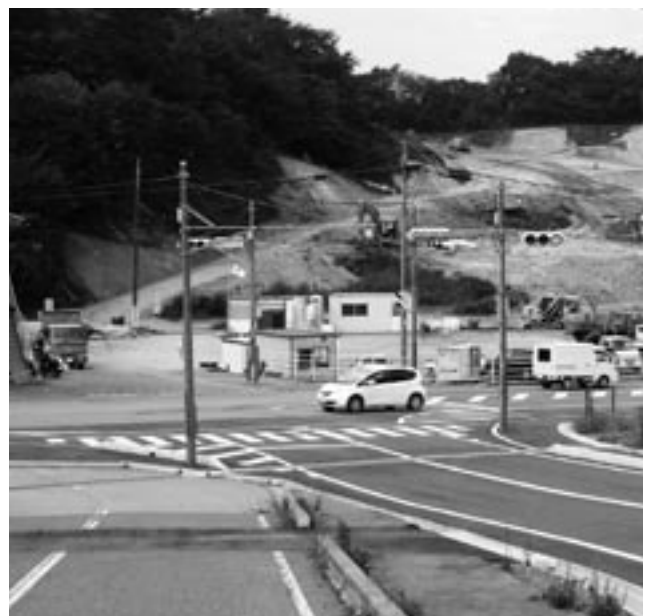
井関定住団地工事中
