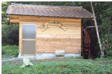
ええのう広石グループ 水車小屋
