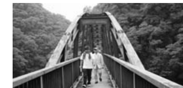
柏岩橋現地調査
