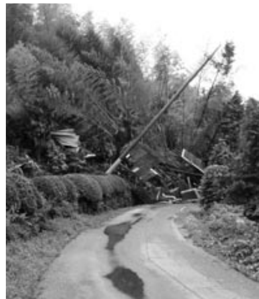
忠原地区地すべり災害
