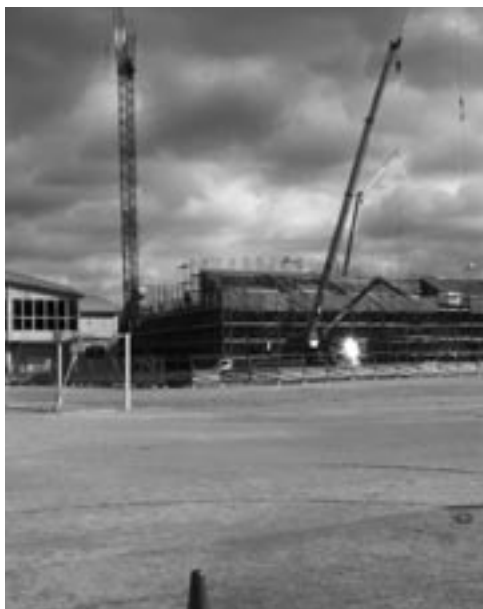
三和統合小学校建設中
