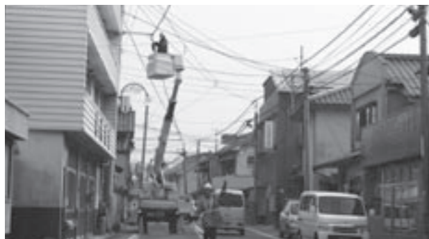
光ケーブル架設工事
