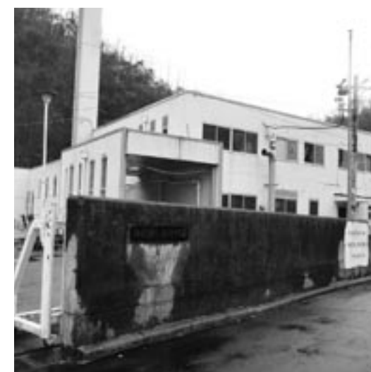
神石郡し尿処理場
