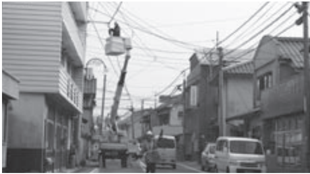
光ケーブル架設工事
