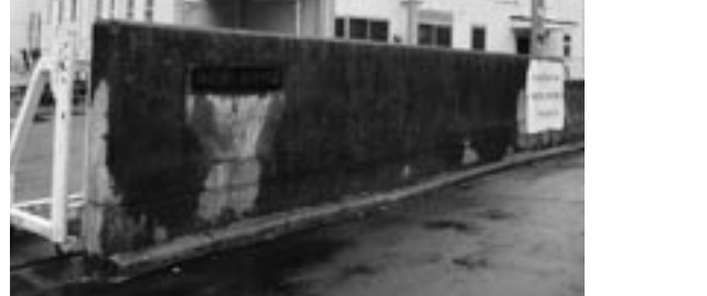
神石郡し尿処理場
