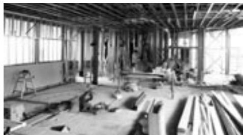
ローソン開店に向け改装中の182ステーション
