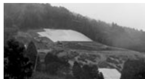
地すべり災害現場復旧状況
