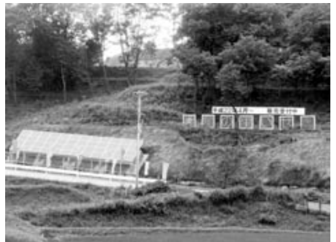
井関定住団地 太陽光発電施設
