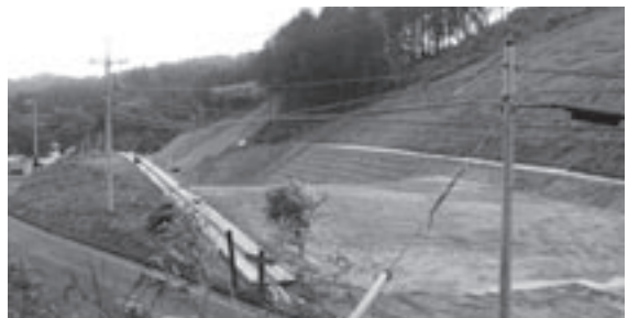
改良工事区間
