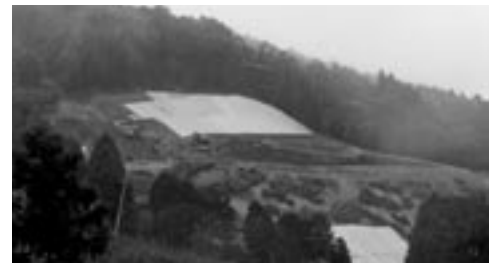
地すべり災害現場復旧状況
