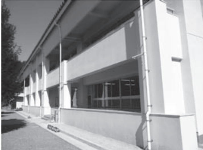
耐震補強工事が完了した豊松小学校
