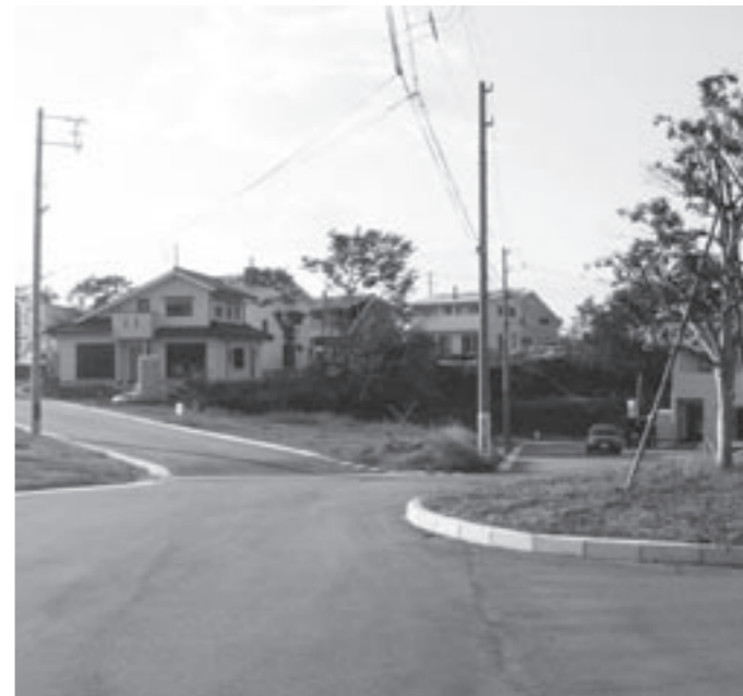
建築が進む「星の里いせき」
