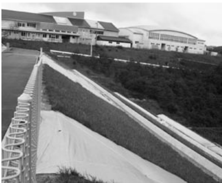
三和小学校プール駐車場の法面崩壊
