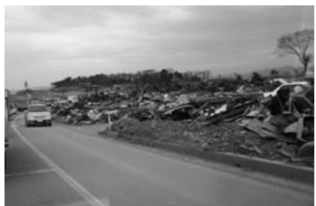
東日本大震災の被害状況
