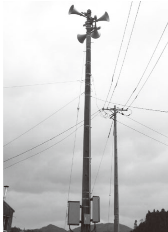
三和地区上に設置の屋外スピーカー
