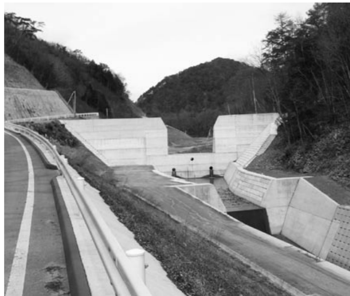
工事中の宮谷川砂防ダム
