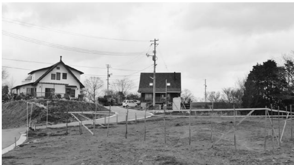
着々と建物建築が進む井関定住団地
