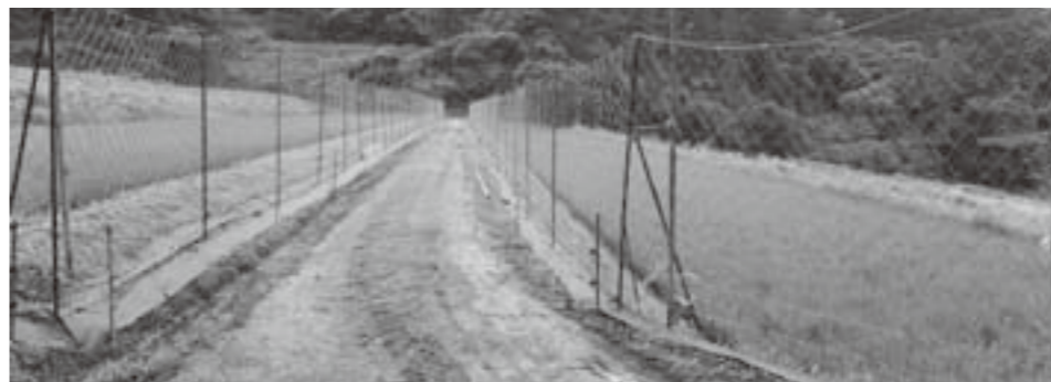
さる用電気柵設置状況（永野地区）
