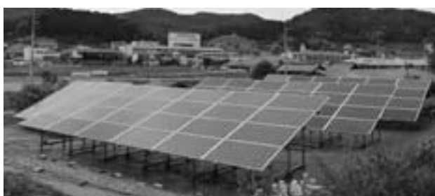
増えつつある太陽光発電パネル設置
