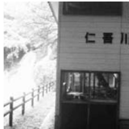
最稼働を待つ仁吾川発電所
