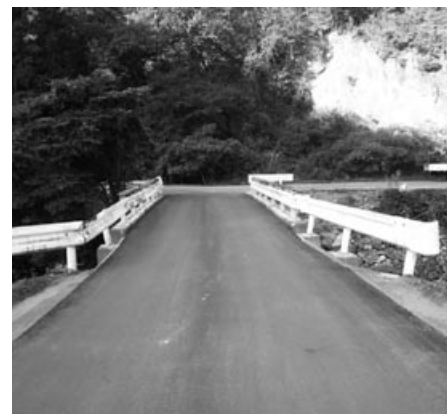
路盤改良工事が完成した橋(三和・大矢)
