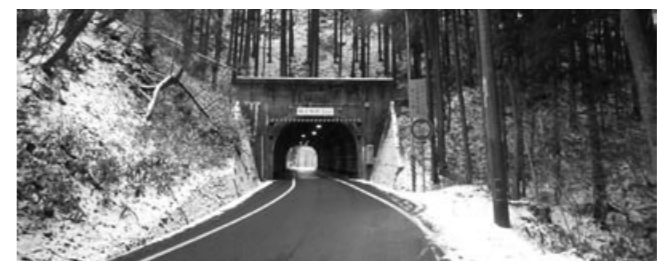
長者ヶ原トンネル
