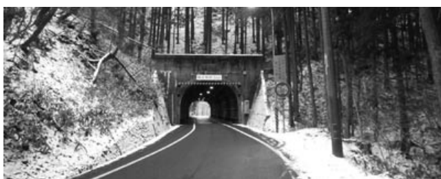
長者ヶ原トンネル
