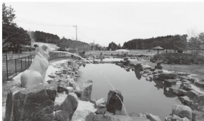
仙養ドッグラン 池の改修完成
