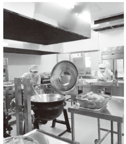
神石小学校 給食棟施設内
