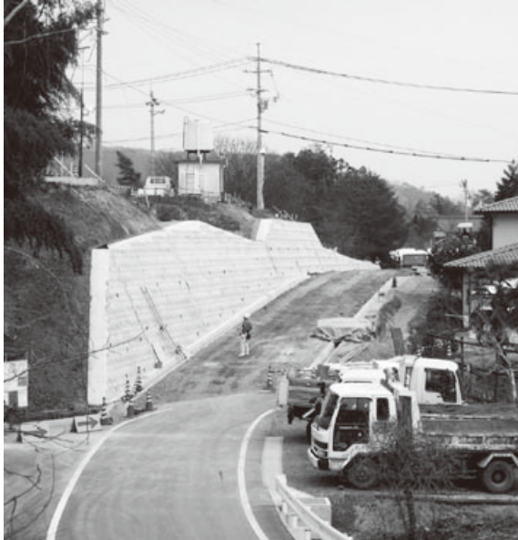
県道木割谷小吹線改良中
