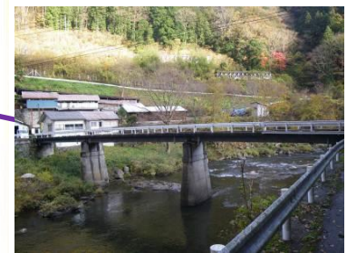
手入橋 L=56.4m(鋼橋) 1973年架設
