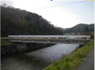
妙見橋 L=21.0m(PC橋) 1991年架設
