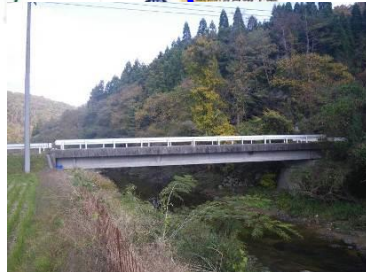
昭十橋 L=22.4m(PC橋) 1983年架設
