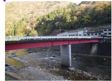
仁滝橋 L=54.5m(鋼橋) 1986年架設
