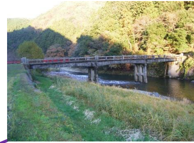
小野橋 L=42.6m(RC橋) 1953年架設
