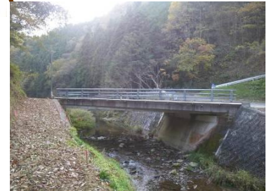
小田橋 L=17.4m(PC橋) 1989年架設
