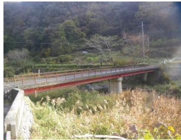
日南原橋 L=29.0m(鋼橋) 1960年架設
