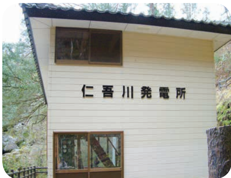
再生が期待される仁吾川発電所
