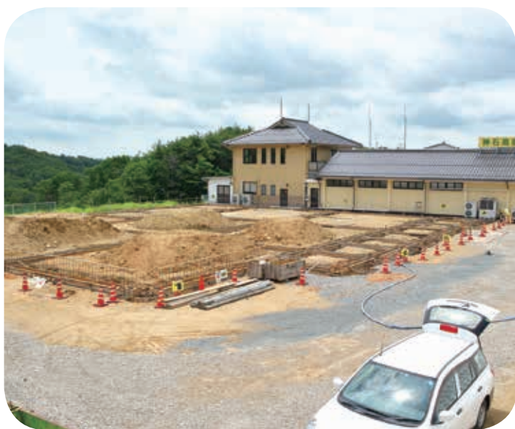
基礎工事中の、道の駅リニューアル現場
