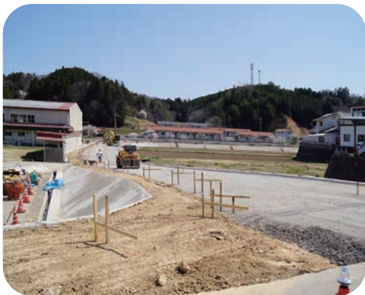
町道小島通学路線改良工事
