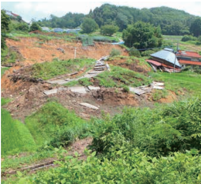
豊松地区笹尾の地すべり災害現場
