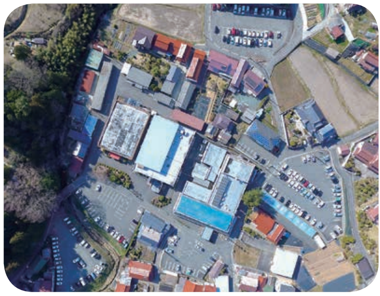
ドローンで上空から撮影した役場周辺
