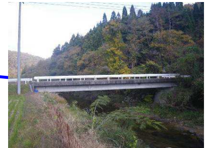
昭十橋 L=22.4m (PC橋) 1983年架設
