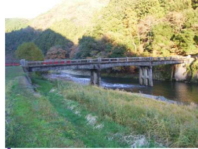
小野橋 L=42.6m (RC橋) 1953年架設
