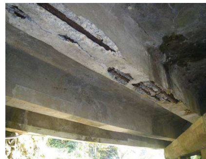
主桁の剥離・鉄筋露出
