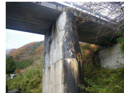
アルカリ骨材反応による橋脚のびびわれ、遊離石灰
