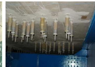
ひびわれ注入工
