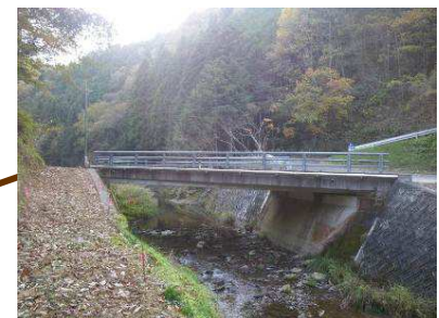
小田橋 L=17.4m (PC橋) 1989年架設
