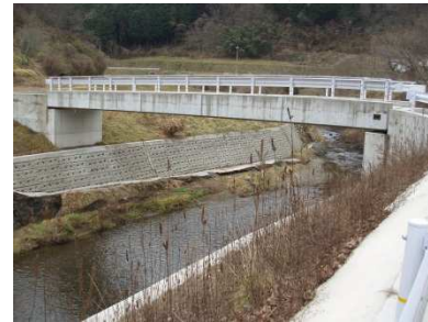
新長洲橋 L=23.1m (PC橋) 2008年架設
