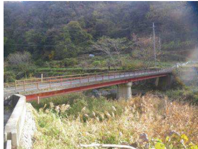
日南原橋 L=28.9m (鋼橋) 1960年架設
