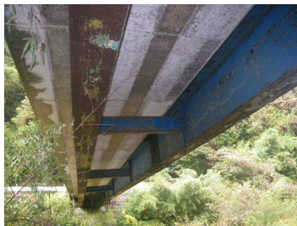
主桁の防食機能の劣化
