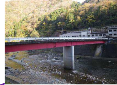
仁滝橋 L=54.5m (鋼橋) 1986年架設
