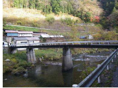
手入橋 L=56.4m (鋼橋) 1973年架設
