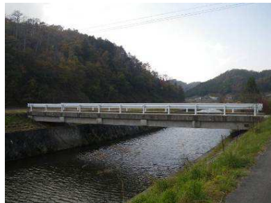
妙見橋 L=21.0m (PC橋) 1991年架設
