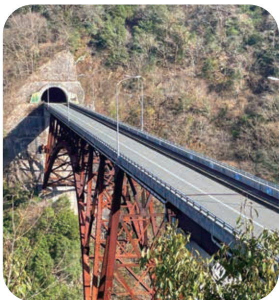
安全柵の設置も予定している福栂川大橋
