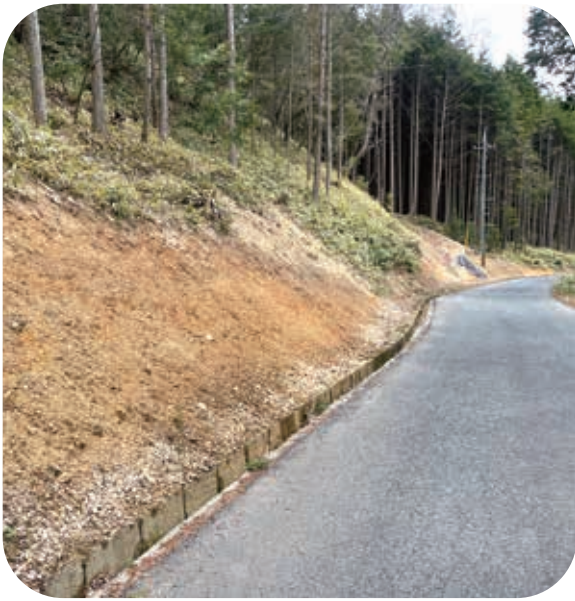
法面保護工をする上組城江線
