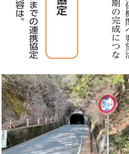
早期改修が望まれる長者原トンネル
