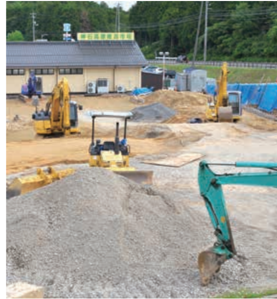
店舗拡張に向け工事中 (182ステーション)
