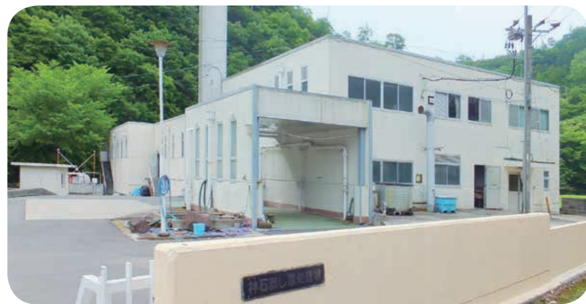
運営を検討中のし尿処理施設
