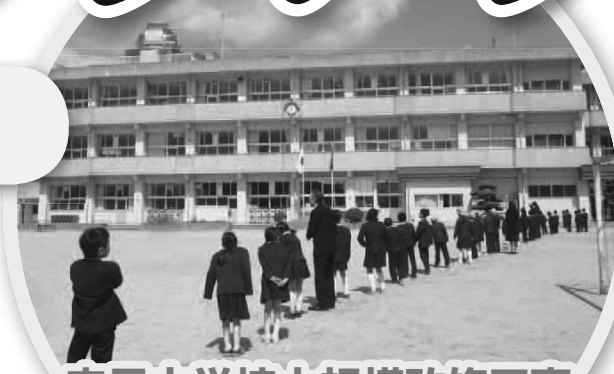
来見小学校大規模改修工事 8000万円
