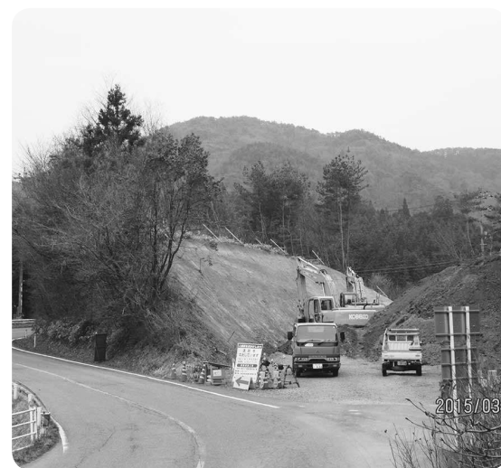
改良中の国道182号
