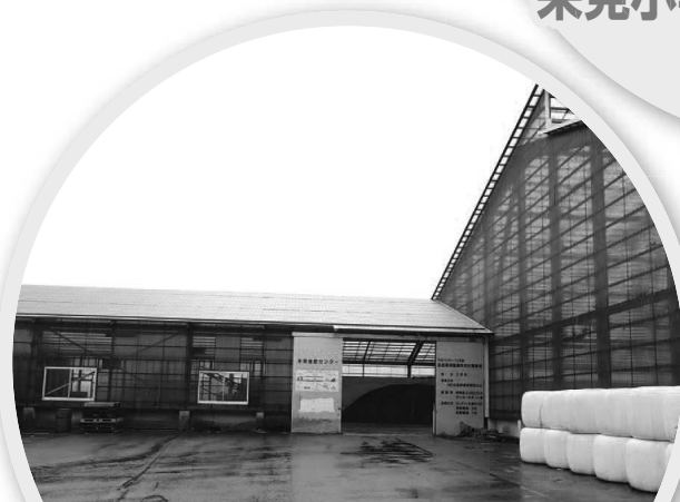
来見堆肥センター改修 7543万円
