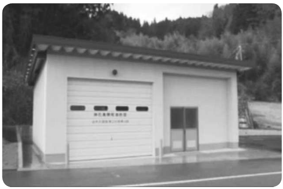
新設された消防屯所(油木地区花済)
