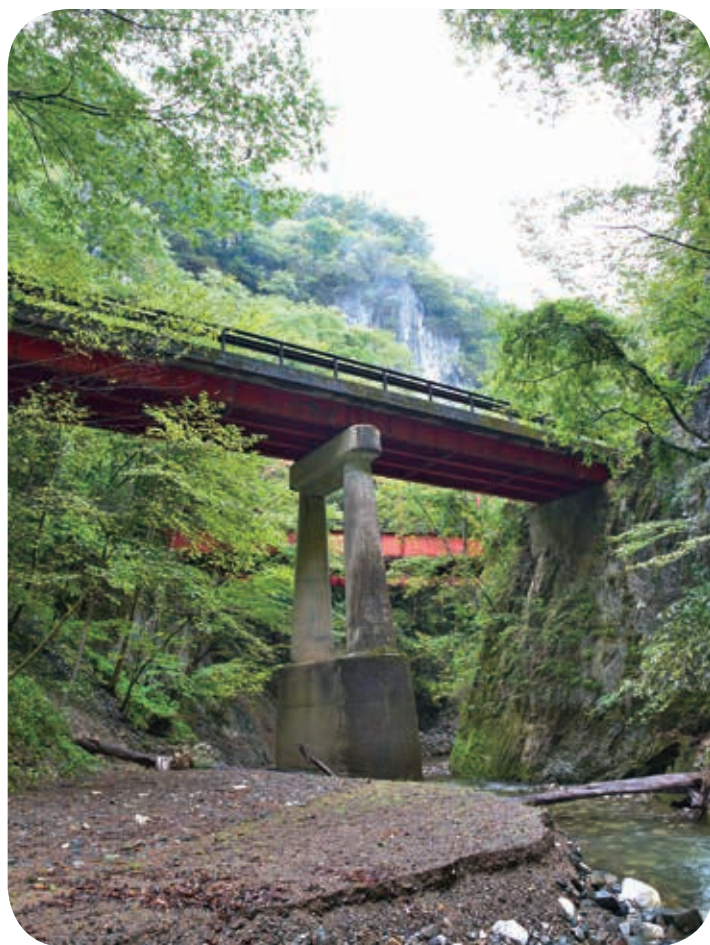
橋梁などは定期的な調査・修繕が長寿命化に繋がる
