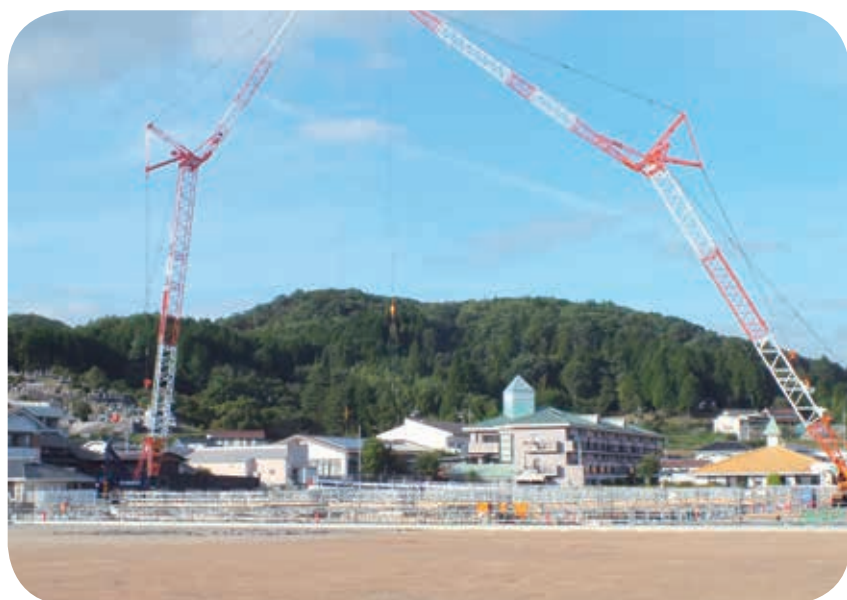
基礎工事の中の新庁舎建設事業
