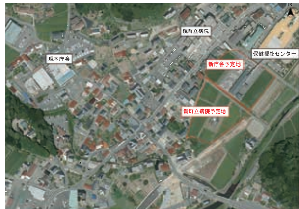
新庁舎・新病院 建設予定地
