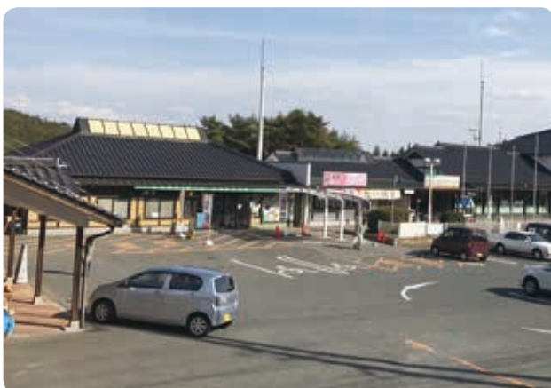
改修が検討される、さんわ182ステーション
