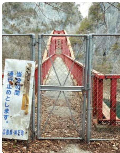
伯岩橋の通行止め表示
