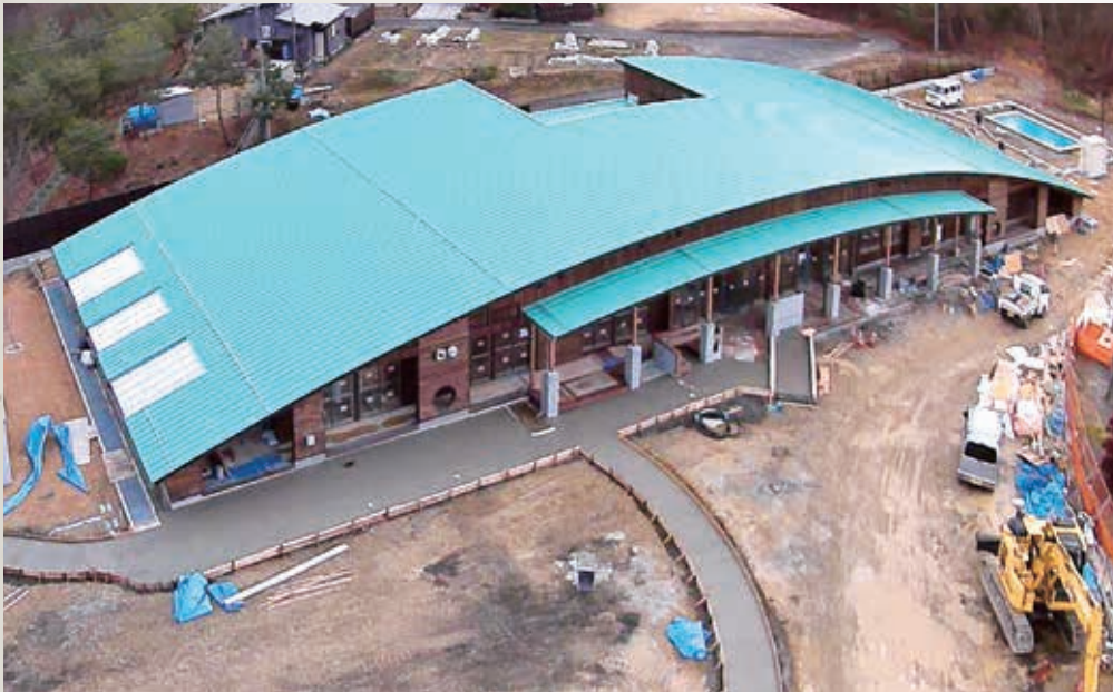
完成間近の「くるみ保育所」
