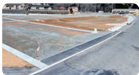
造成が完成した保育所建設地
