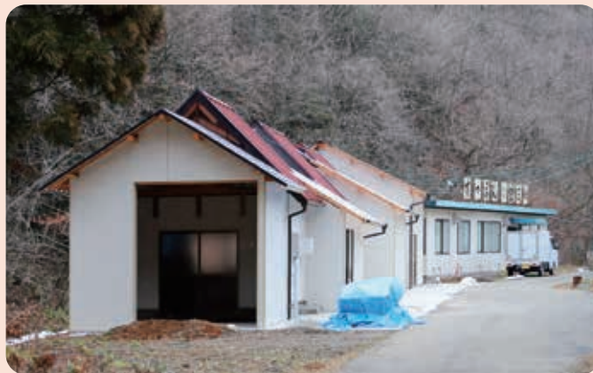
建設中の加工施設
