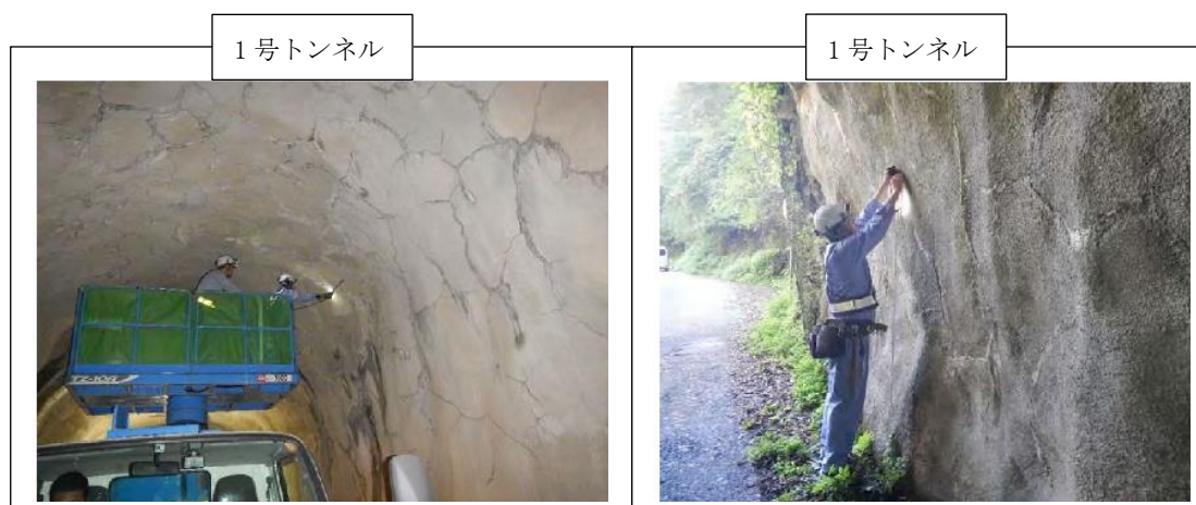
図1-3 トンネル定期点検状況（平成30年度）
