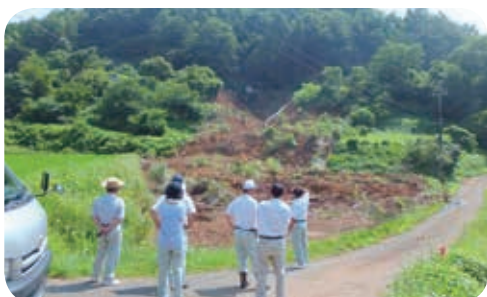
被災現場を視察
