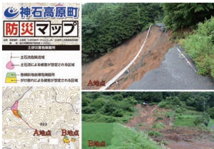
大規模に崩壊した神石地区の広域農道と、防災マップの比較
