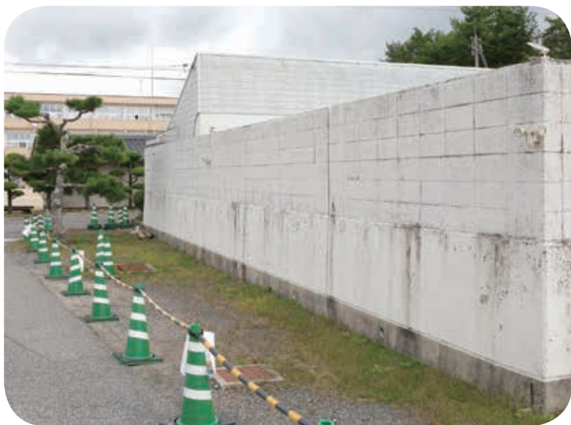
撤去される来見小学校のプール壁（撤去後はフェンスを設置）
