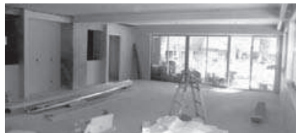
寄宿舎の内装工事（1階食堂）
